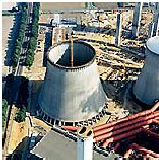
Φωτογραφίες 2 – 3. Κατσκευή πύργου ψύξης στη Γερμανία και στρώσιμο δρόμου στο Ηνωμένο Βασίλειο με τέφρα
