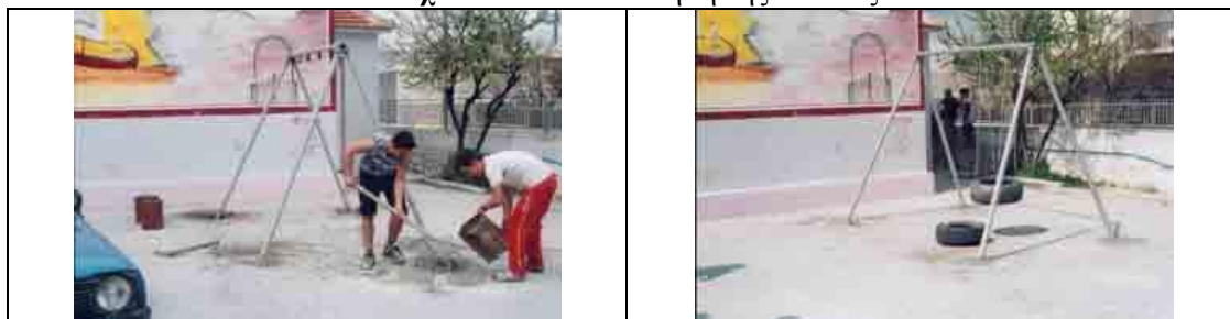
Σχέδιο 2. Η τοποθέτηση της κούνιας
